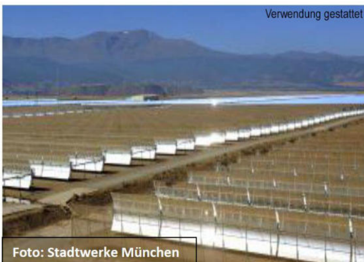
Solkraftwerk mit sogenannten Parabolspiegeln
